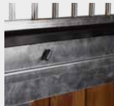
Schloss für die Verbindung von oberen und unteren Türflügeln
